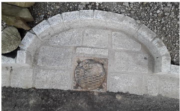
Schachtabdeckungen hat die Materialverdichtung maschinell zu erfolgen, damit spätere Setzungen ausgeschlossen sind. Schachtabdeckungen in Belagsflächen sind nach den folgenden Detailrichtlinien zu versetzen.
