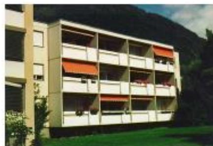
Balkone erheben, da auf beiden Seiten geschlossen und über die ganze Fassadenlänge gebaut
