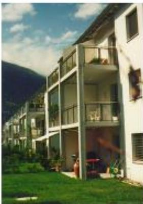
Balkone erheben (solide abgestützt)
