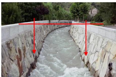
Die Flächen der Ufermauern sind nicht bei den Gewässern zu definieren. Die Ufermauern sind bei den anschliessenden Bodenbedeckungsarten aufzunehmen.
